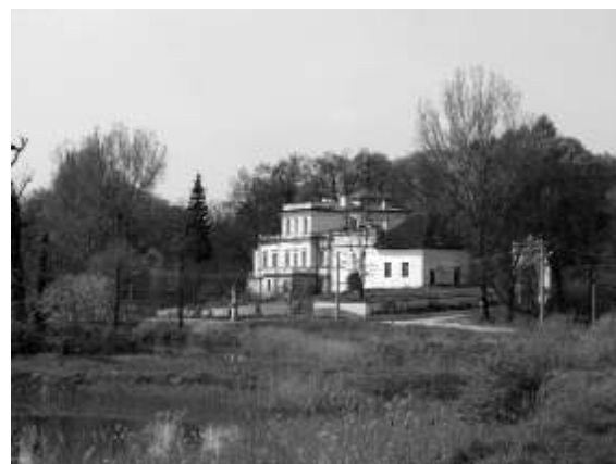
▲ Rys. 1. Sancygnów, widok na pałac Deskurów od strony parafialnego kościoła, J. Niewiadomska
