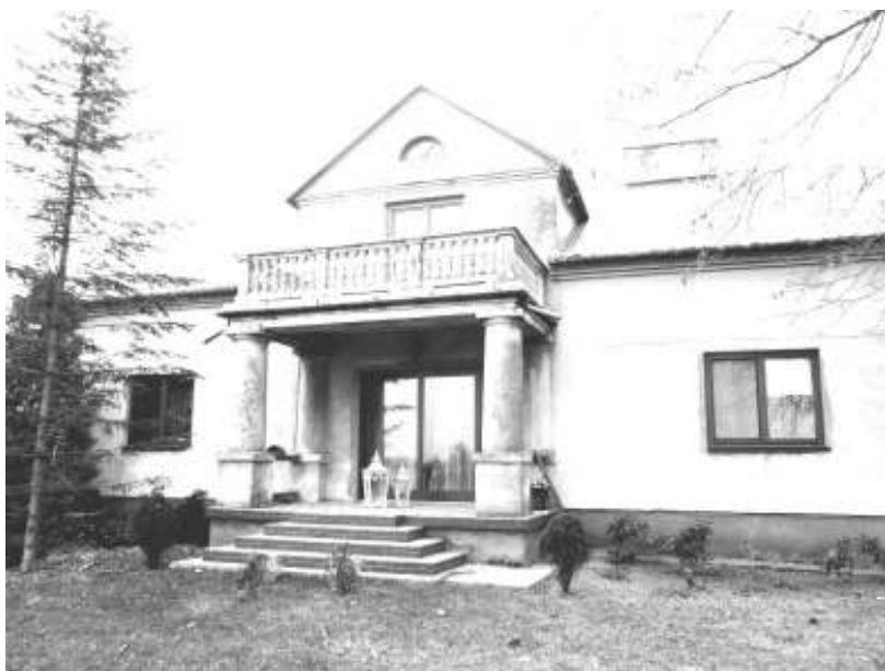
Ryc. 16 Budynek mieszkalny właścicieli firmy ogrodniczej warunkujący charakter miejsca.
